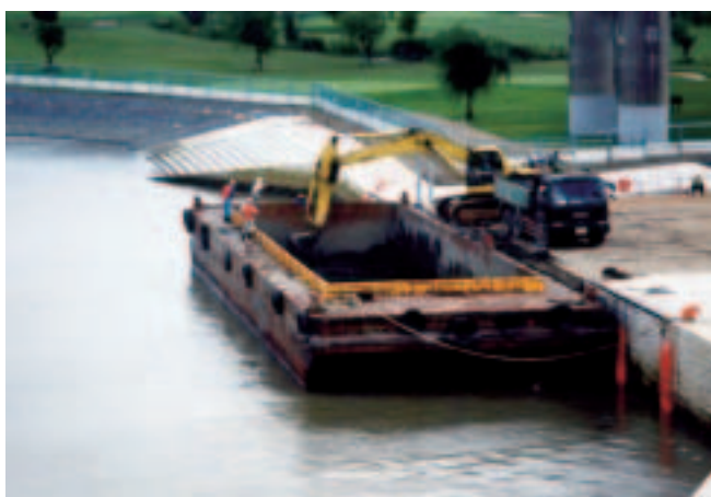
写真-4 リバーステーションを利用した土砂運搬
