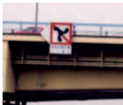
写真-3 橋梁への標識の設置
