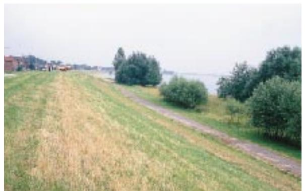
写真 - 14 エルベ川堤防。以前の湿地帯を取り戻すため92年に引き堤を行い、この地区で2.3haを新たな自然保護地帯として確保した。
