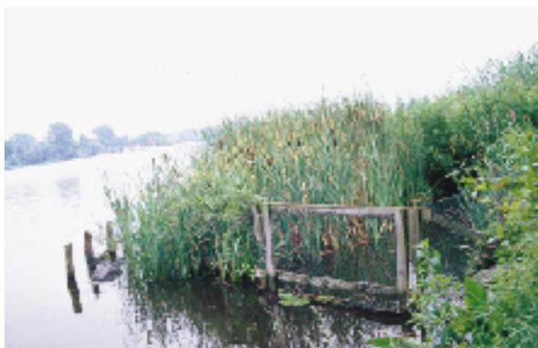
写真 - 15 アルスター湖岸の植栽。アルスター湖におけるヨシ原の重要性が再認識され、湖岸の植栽が実施されている。湖岸の土砂流出や波・鳥類の影響を防ぐための壁や柵といった様々な工夫が見られる。
