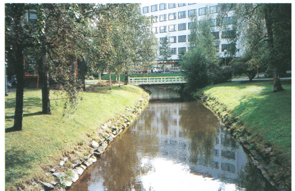
⑨自然石護岸の完成状態。緑と水のいい状態。色が茶色いのは汚濁だけではなく元からのもの。
