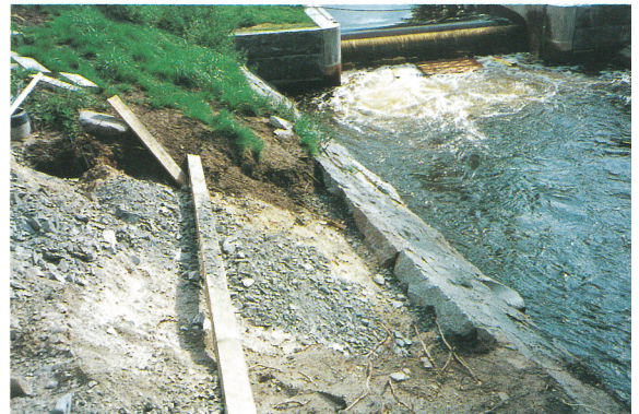
⑧護岸工事中の状態。自然石の護岸でモルタルは使っていなかった
