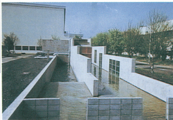
写真1 実験水路全景
