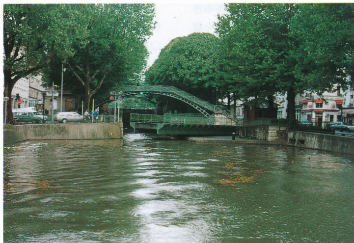
パリ市内。運河には橋が多く、交通量も多いが、あくまでも船が優先されている。これは、90度に回転する橋。右側に、橋の管理所があり、船体を確認すると、橋を動かす。向こう側に見えるアーチ橋は歩行者専用。
