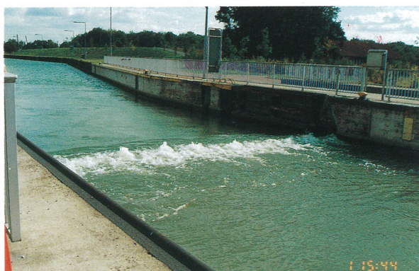
門扉が水中へ沈んでいく。この視察でみた門扉の形式としては珍しいものだった。水深は約3mほど。
