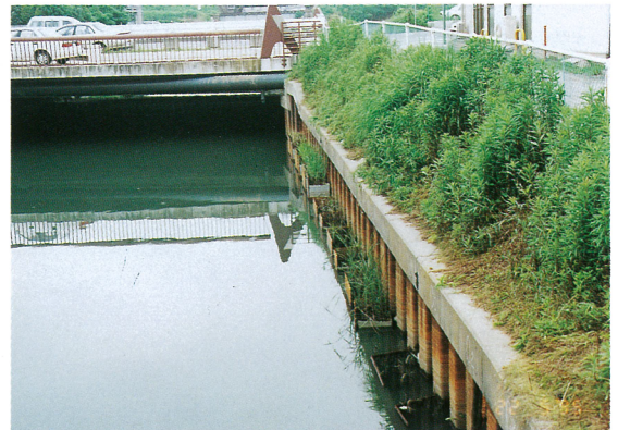
写真-2 植栽フィン設置直後の状況
