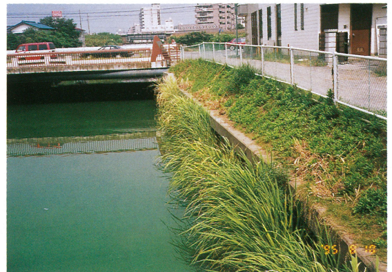
写真-3 植栽フィン設置5ヶ月後の状況
