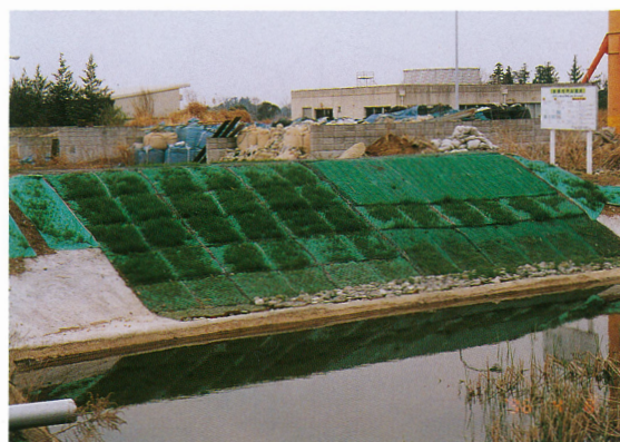
写真-1 植生鋼矢板護岸工法 (左：かごマット方式 右：植生マット方式)
