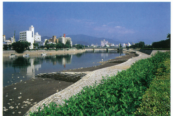
写真一 広島県太田川基町護岸
