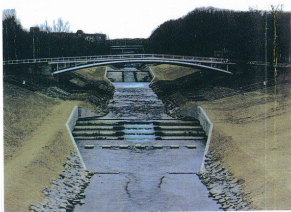
実際の落差工
