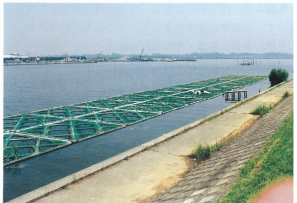
写真二 施工直後の人工浮島
