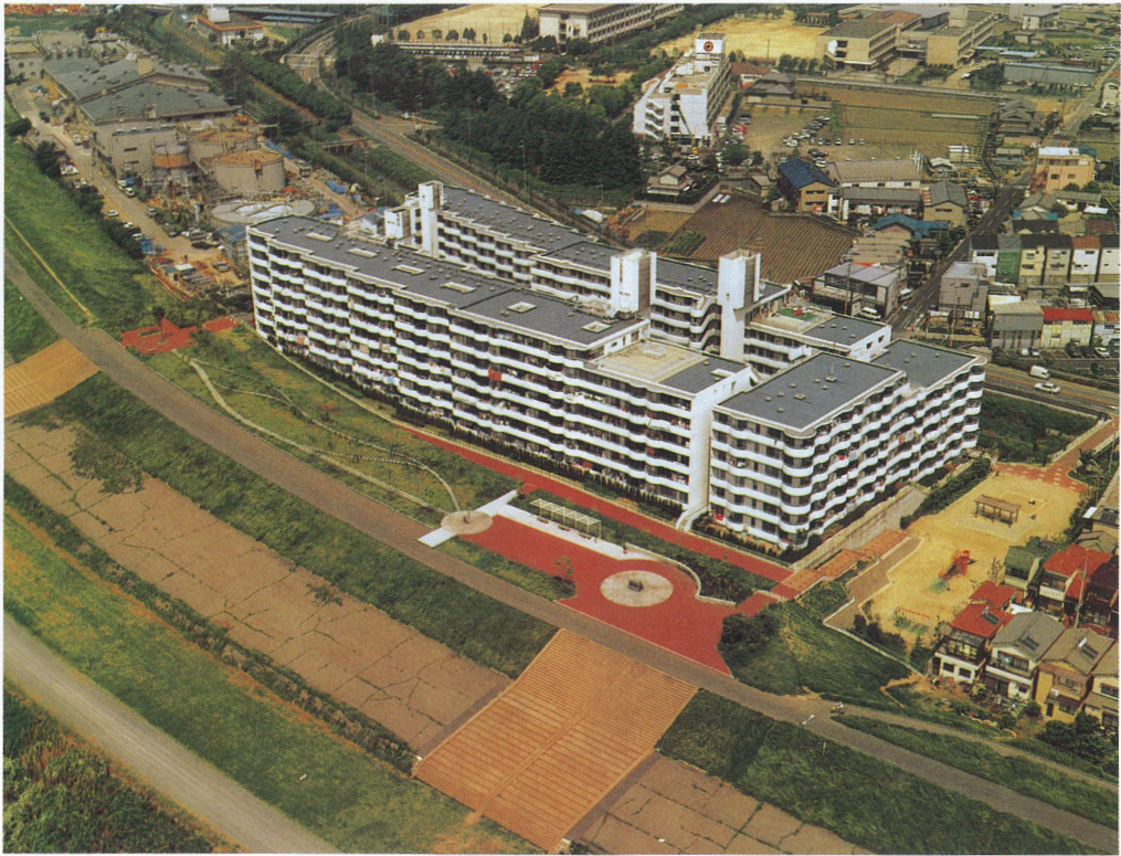
スーパー堤防上に建設されたマンション（淀川出口地区・大阪府枚方市）
