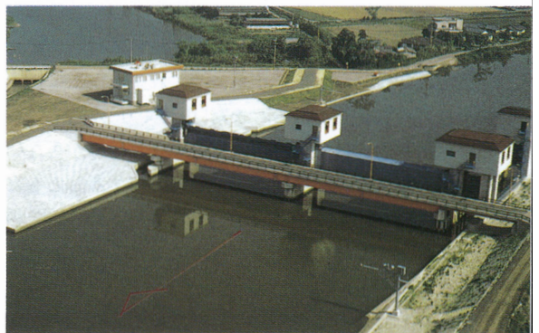
かさね 碓ノ江堰特定構造物改築事業（改築後）
