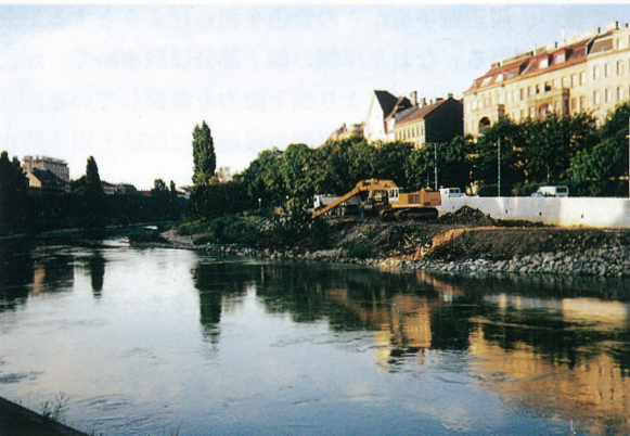
写真一 4 ドナウ運河における近自然型河川工事
