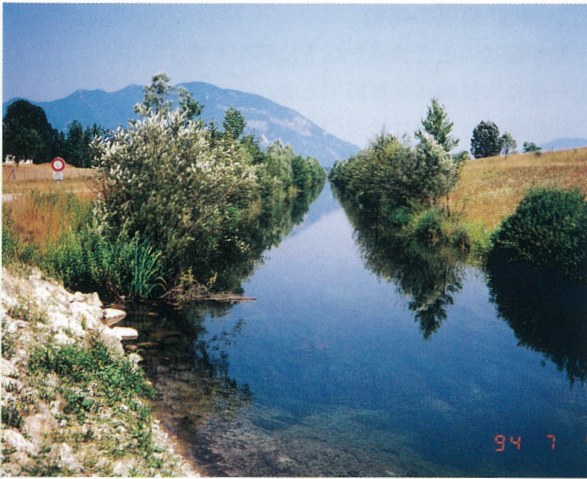
写真-13 ローヌ川ペリー地区における運河沿いの排水路
