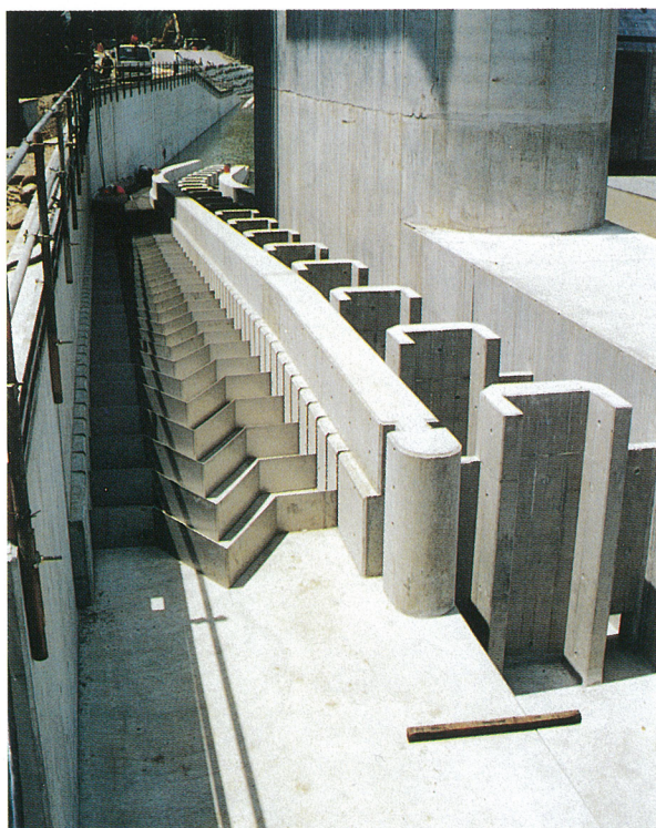
写真－4 豊川用水牟呂松原頭首工 アイスハーバー式と舟通し型デニールを用いた例
