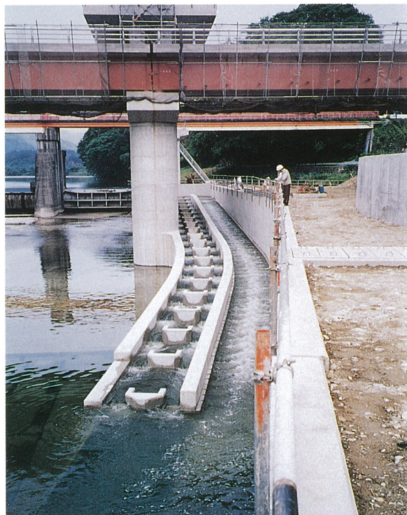
写真－4 豊川用水牟呂松原頭首工 アイスハーバー式と舟通し型デニールを用いた例
