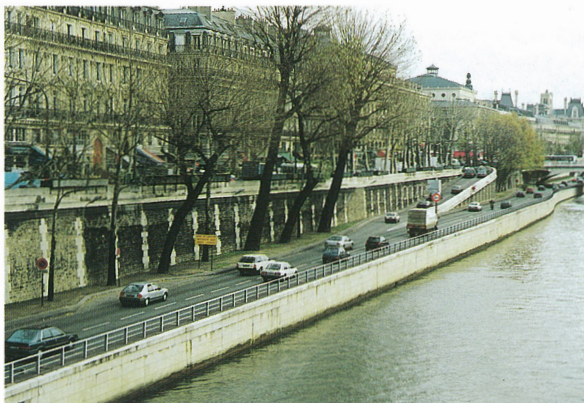
写真一十九 セーヌ河とボンビドー通り/並木の保存、低水護岸にみえる石貼りに注意
