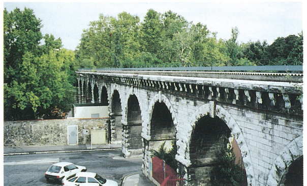
写真一〇 カナルの水路橋(公園到達の直前)
