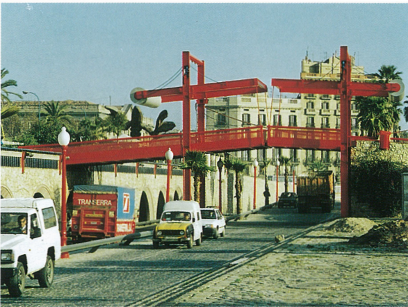
写真一 2 埠頭広場と都市側テラスを結ぶハネ橋の歩道橋/左奥はバルセローナとのつなぎのポイントにおかれた現代彫刻
