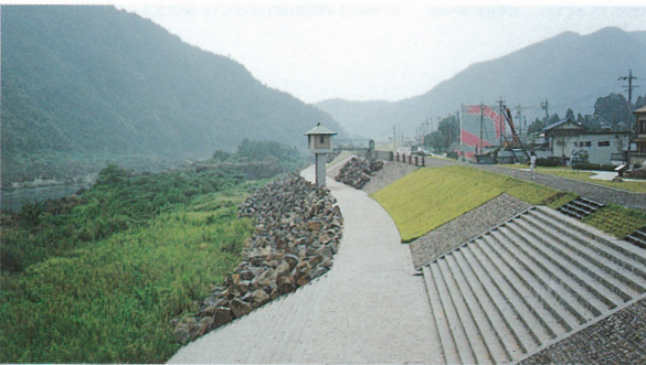
写真一 岩組護岸と排水樋管
