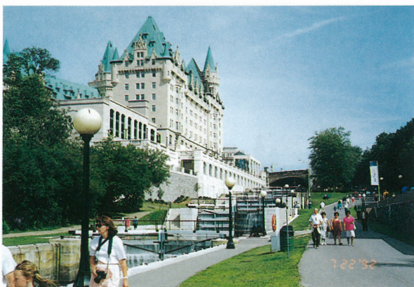
写真-5 オタワ川合流部の水門
