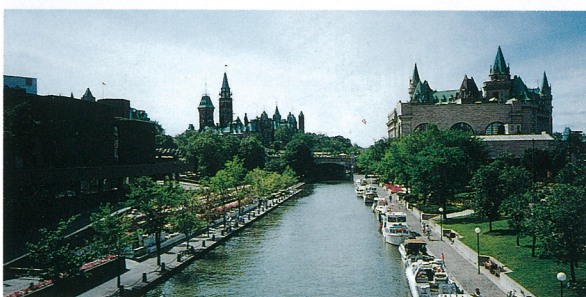
写真－3 市街部でのリドー運河
