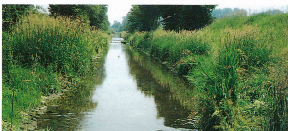
写真2 再改修未着工区間
