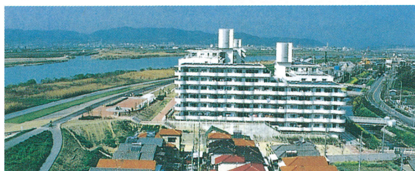
淀川出口地区の高規格堤防の整備状況
