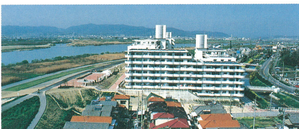
淀川出口地区の高規格堤防の整備状況
