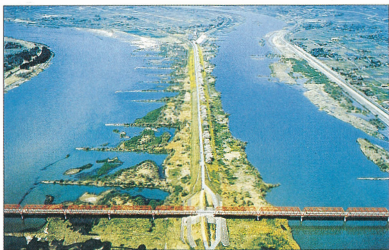
東海大橋付近の背割堤
