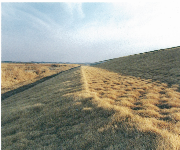
写真一 江戸川の緩傾堤防
