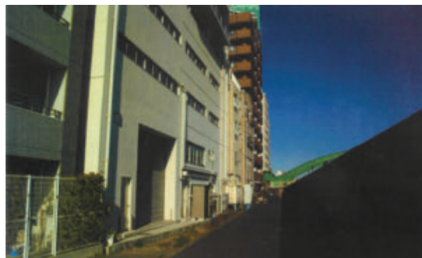
▲改装前の隅田川沿いの物件
