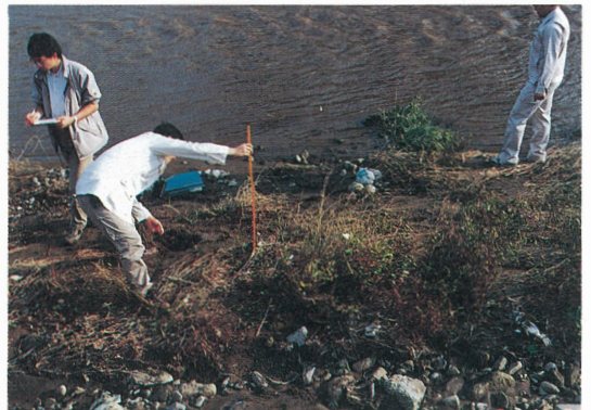
写真-6 出水後(土砂堆積約50cm)
