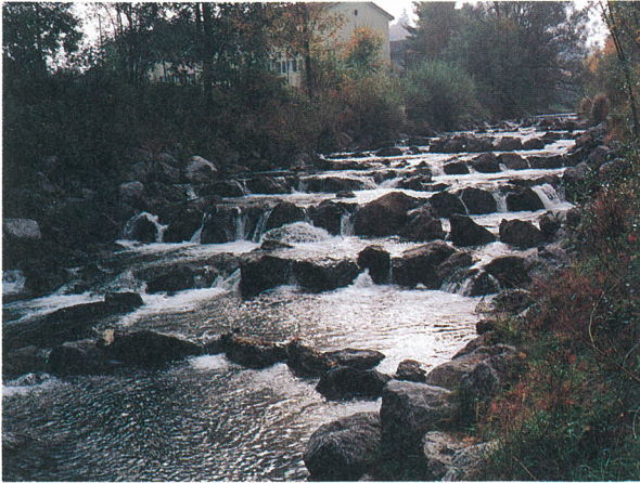
ドイツバイエルン州、シュラッハ川の多段落差工
