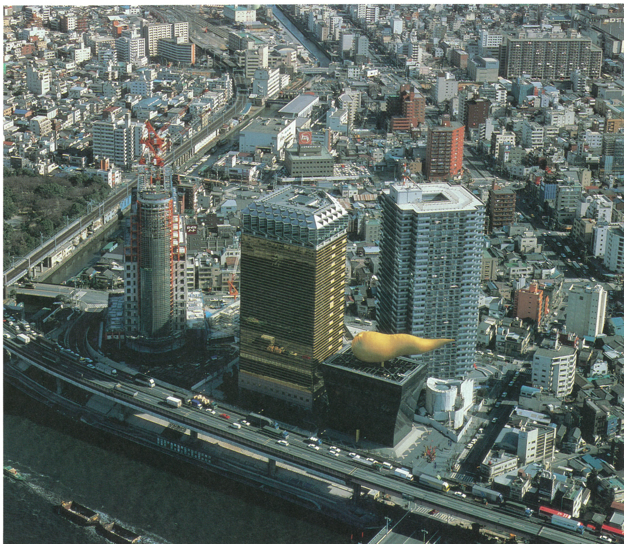
写真-1 吾妻橋一丁目地区開発全景
