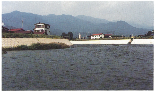
写真-5 瀬と淵が平瀬化した区間
