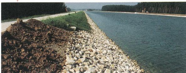
練り石積み護岸の上に土を覆い植栽する
