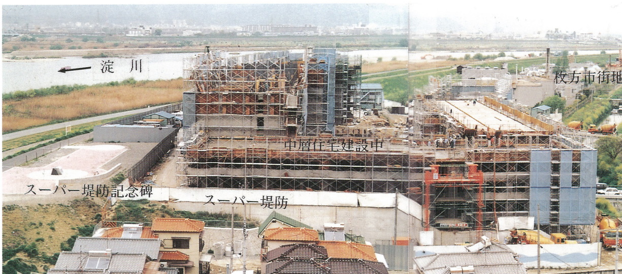
出口地区スーパー堤防上での中層住宅の建設（平成2年4月下旬）
