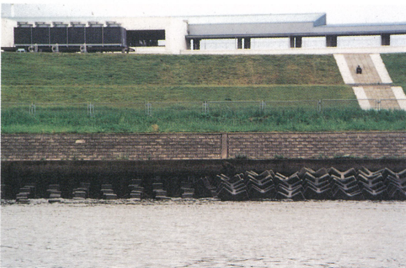
写真-5 堤防の緑により護岸の直線性、かたさが緩和されている。
