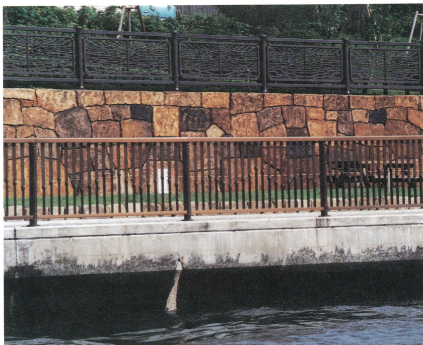
写真-4 隅田川大川端のコンクリート護岸
