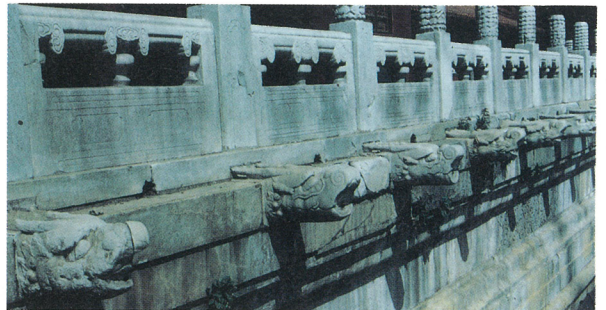
写真-6 北京故宮の排水処理用の龍の顔。汚れ防止の為に作られたものではなく、雨天時の排水を龍により勢よく出し、見せる為に設けられている。結果的に汚れ防止に役立っている。
