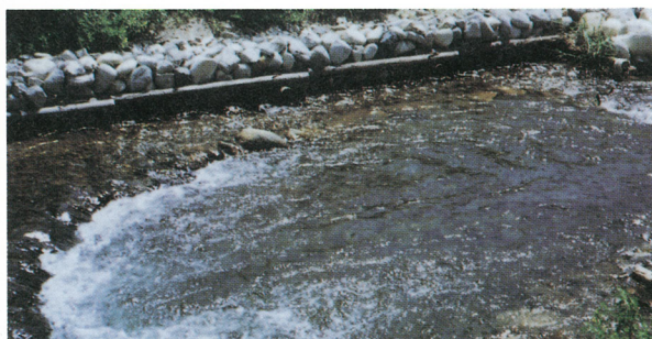
魚類等の育成環境に配慮した落差工
