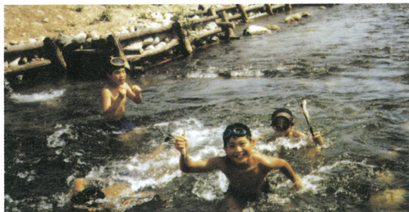
天然材と自然石を活用した木工沈床(根固め工)
