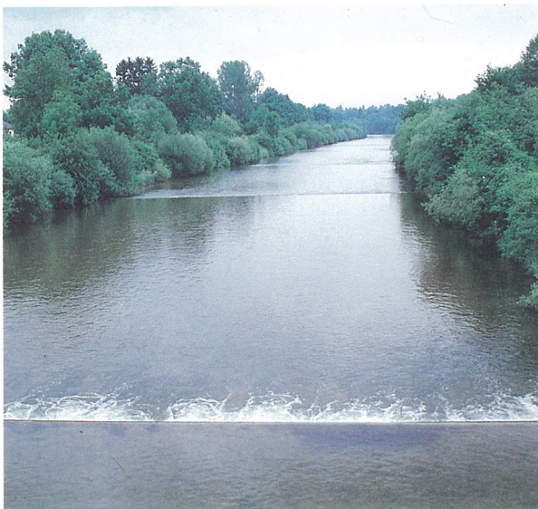
一 落差工 (バイエルン州:マンファール川) — 直線的に作られている従来工法の落差工
