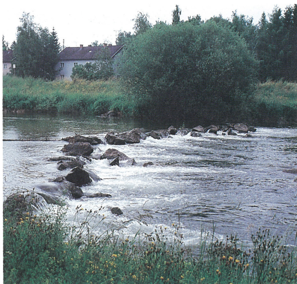
巨石群をスロープ状に並べることによって整備された落差工、多様な水の 流れは川を活性化させ、生物にとって多様な生息環境を与えることができる。
