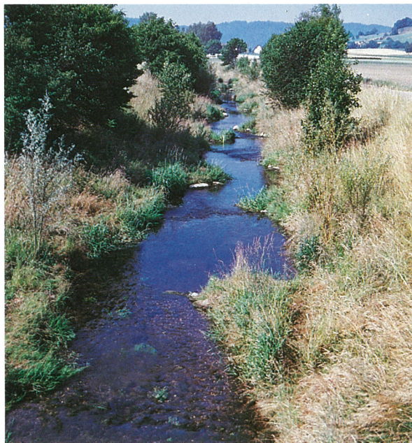
この川の再改修にあたっては川の要所を水制のように石やヤナギで固定したり落差工を設けることによって、河岸を植生でソフトに防御し、河道には瀬や淵を形成している。再改修後はこの区間のマスの生息数が3倍になっており、瀬と淵等の形成がいかにも魚に有益であるかを物語っている。
