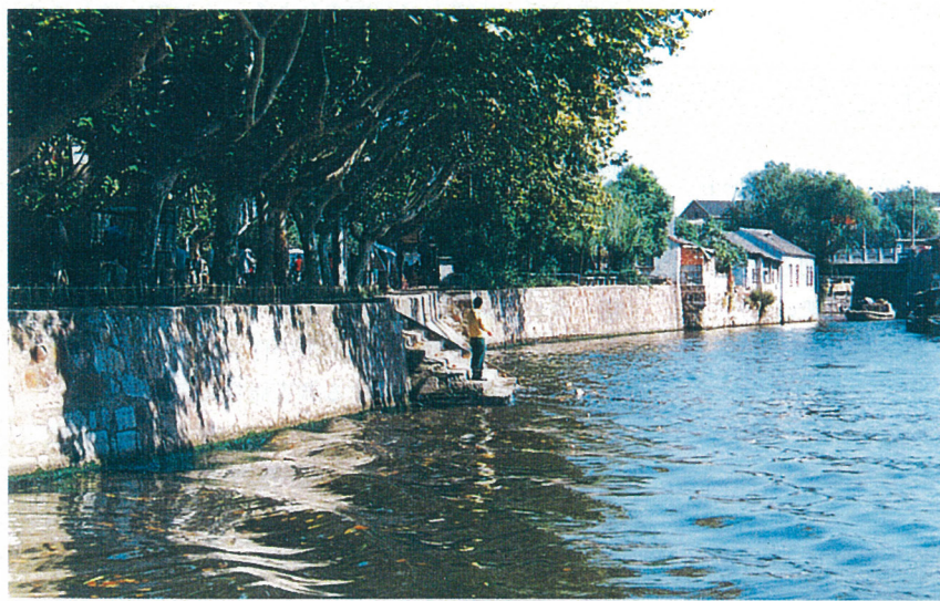
無錫の運河沿いには圧倒的な緑と階段護岸が配されている。
