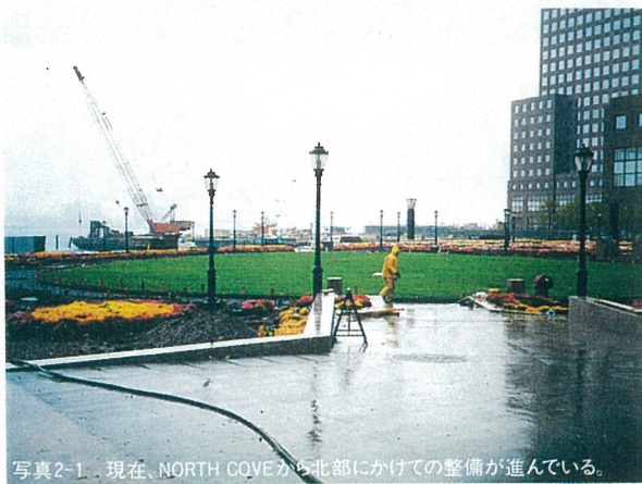
写真2-1 現在、NORTH CQVEから北部にかけての整備が進んでいる。
