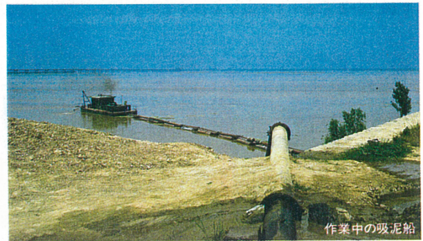
小堤で囲まれた沈積地への放流
