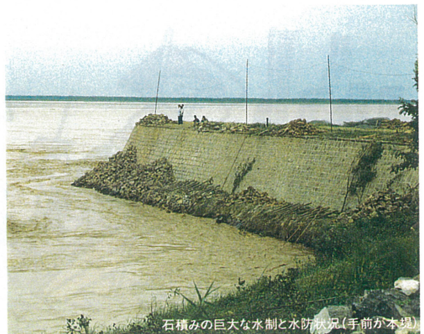
拡幅の完了した黄河大堤
