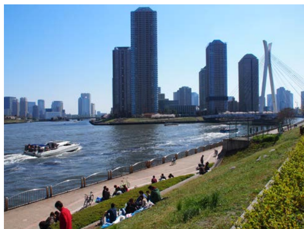
スーパー堤防整備によって開放的な水辺景観に 生まれ変わった大川端地区（隅田川）
