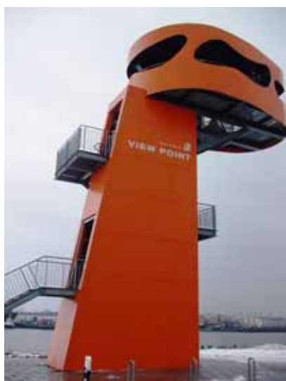
工事現場を見る塔
