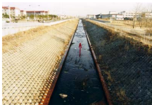
直線化された河川
