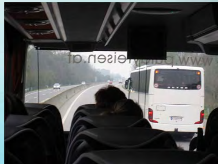
高速道路の中央分離帯もドナウ川氾濫時は堤防として機能するように造られています。 （移動途中の高速道路にて）
