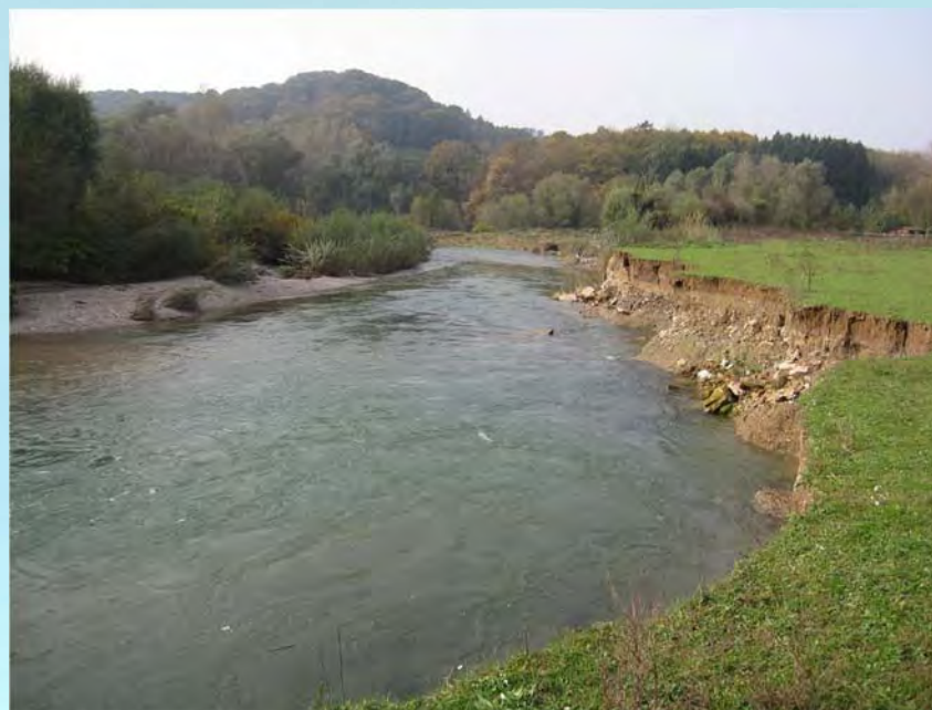
河岸浸食のスピードをモニタリング
