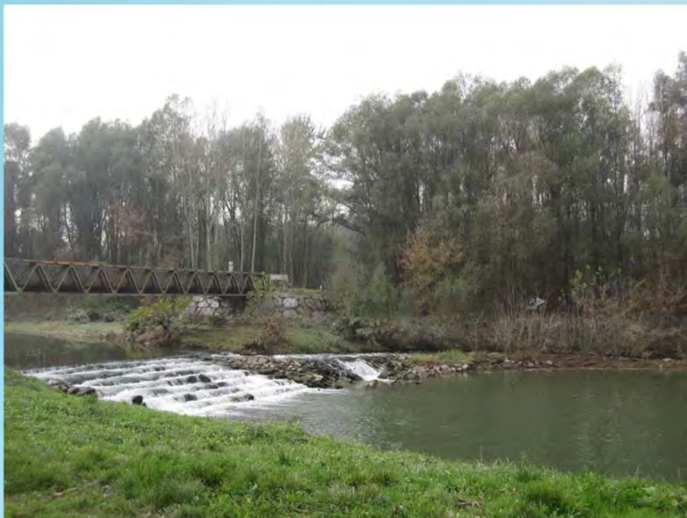
Melk川河口部の堰と魚道（左岸側・奥）の全景
