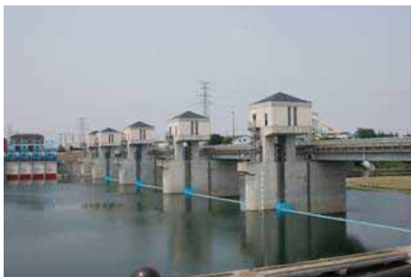
農林水産省が改築した六堰頭首工
