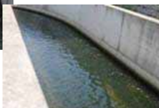
流水改善水路
