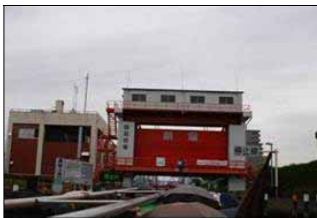
パナマ運河閘門形式の扇橋閘門（小名木川）
