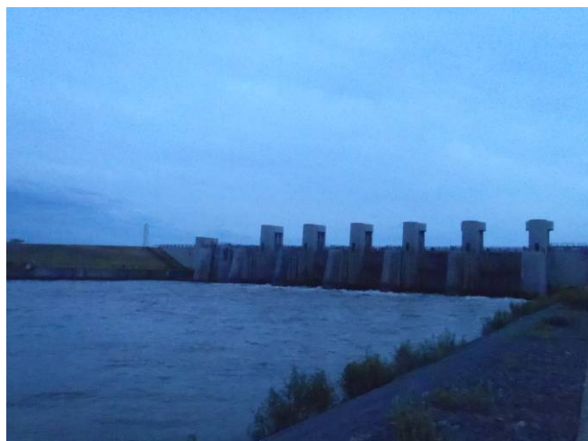
図 1 5 大河津分水洗堰（信濃川本川側）
