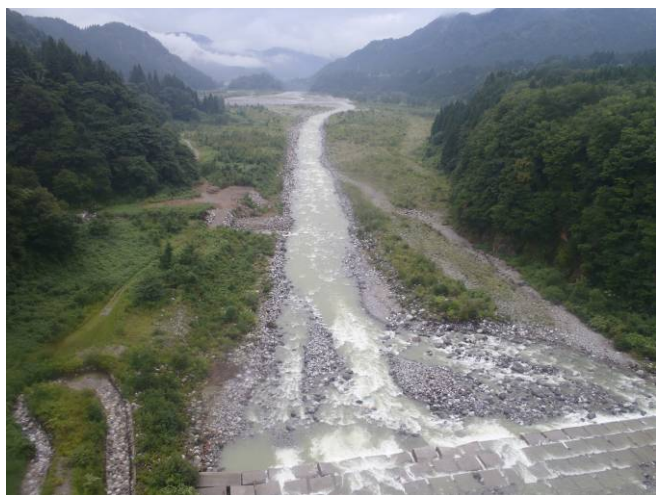
図 12 常願寺川の床固群
