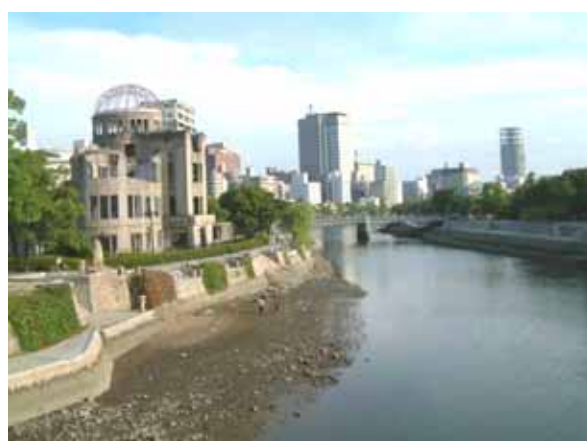
②原爆ドーム 下流方向を望む
