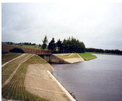
連続ブロックシステム（グラスコン）の使用例（韓国）
