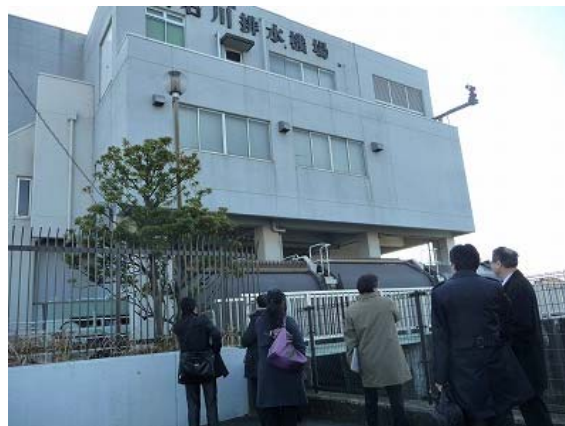
伝右川排水機場
