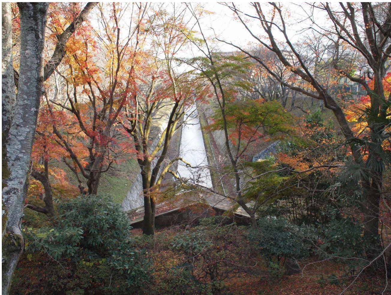
撮影：2010 年 12 月（滋賀県大津市第一疏水トンネル入口）
