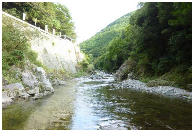
③鞍瀬川自然再生事業研修予定箇所 (上：上流側、下：下流側)
