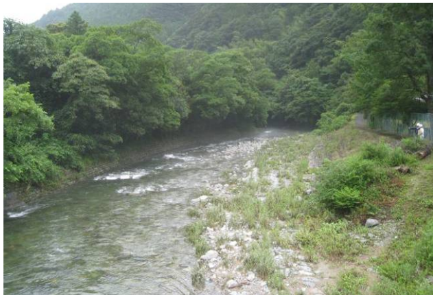
②明河キャンプ場周辺の鞍瀬川の状況 (写真右側ののり面が親水護岸)
