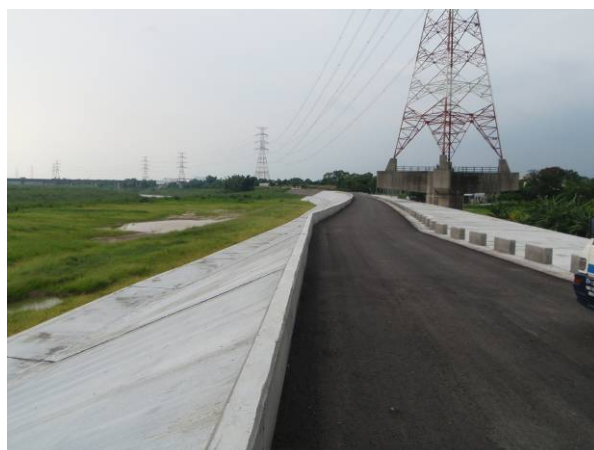
曾文溪災害復旧後の堤防状況（台南）
