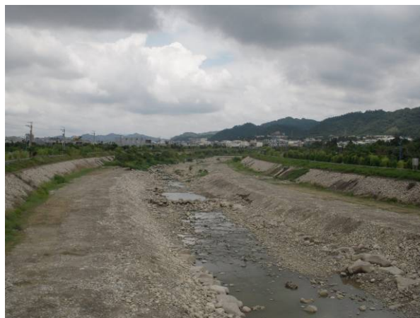
大里溪中流部改修済状況（台中）
