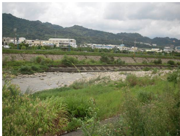
大里溪水衝部根固移動状況（台中）
