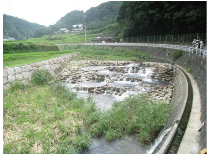
麓川の魚道（5m 程の落差を解消している）
