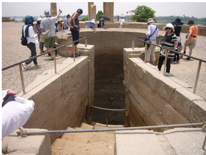
中流コムオンボ神殿のナイルメーター(水位計): かつてナイルの氾濫水位は農政上極めて重要だった
