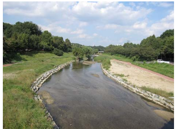
再生された区間を望む
