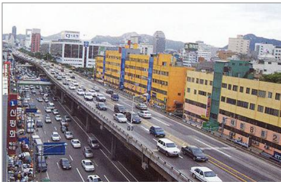
再生事業前の清溪川を覆う高速道路 （第 4 回 ARRNI 国際フォーラム資料より引用）
