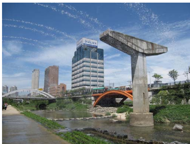
かつての橋脚をそのまま保存
