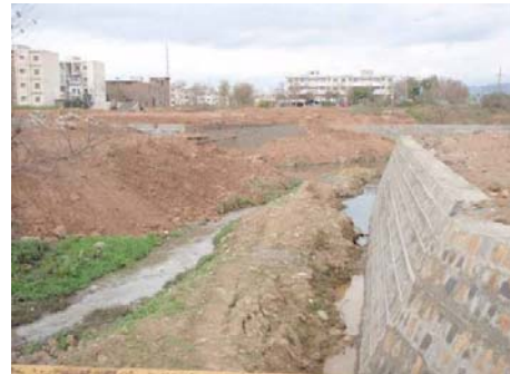
川の中へ土砂が堆積 (パキスタン・ライヌラー川)
